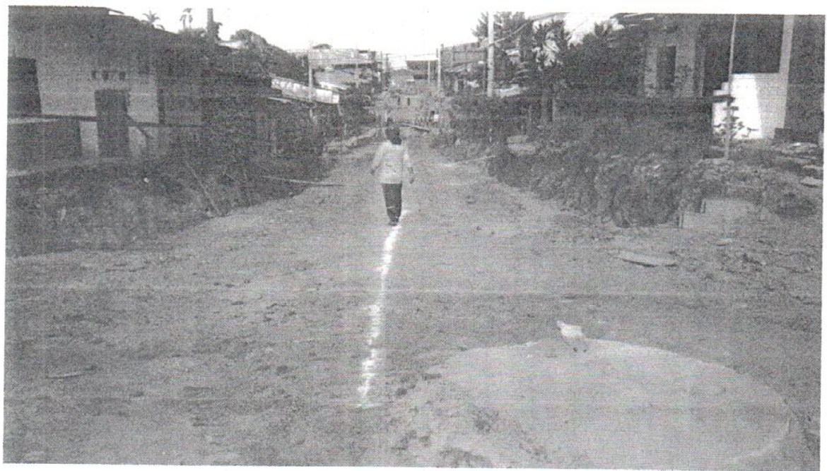
TRAZO PARA EXCAVACION TUBERIA MATRIZ LA C-7
