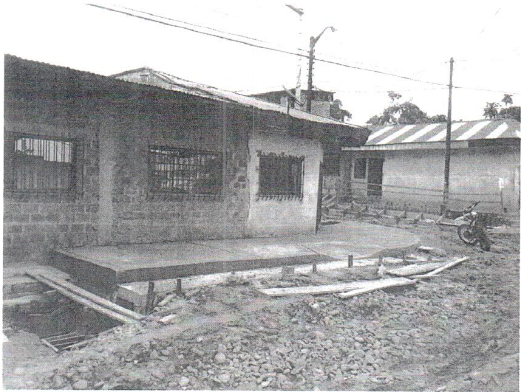
VEREDA CON ACABADOS FINALES
