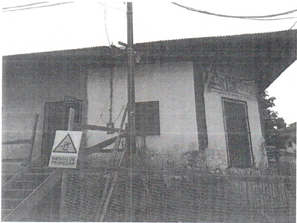
SEÑALIZACION FRENTE VIVIENDAS PARALELOS A LA OBRA.
